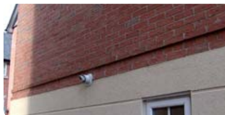
Fachada protegida con Nanoprotec®
